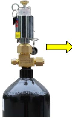
图 23 拔出驱动气体瓶组上电磁型驱动装置保险销
