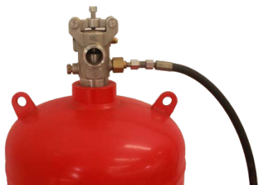
图 34 不锈钢容器阀软管连接
