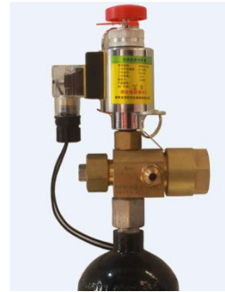
图 52 旋紧电磁型驱动装置
