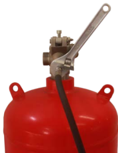
图 36 不锈钢灭火剂瓶组容器阀上拆卸软管
